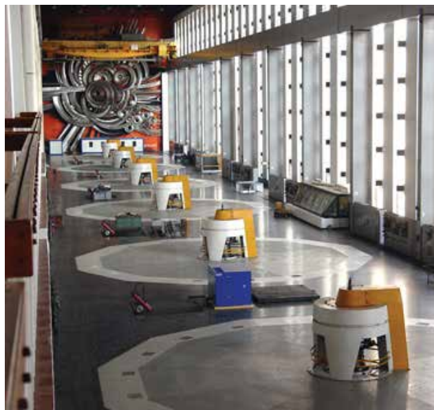
Хидроелектрана "Бердап" - Агрегати
