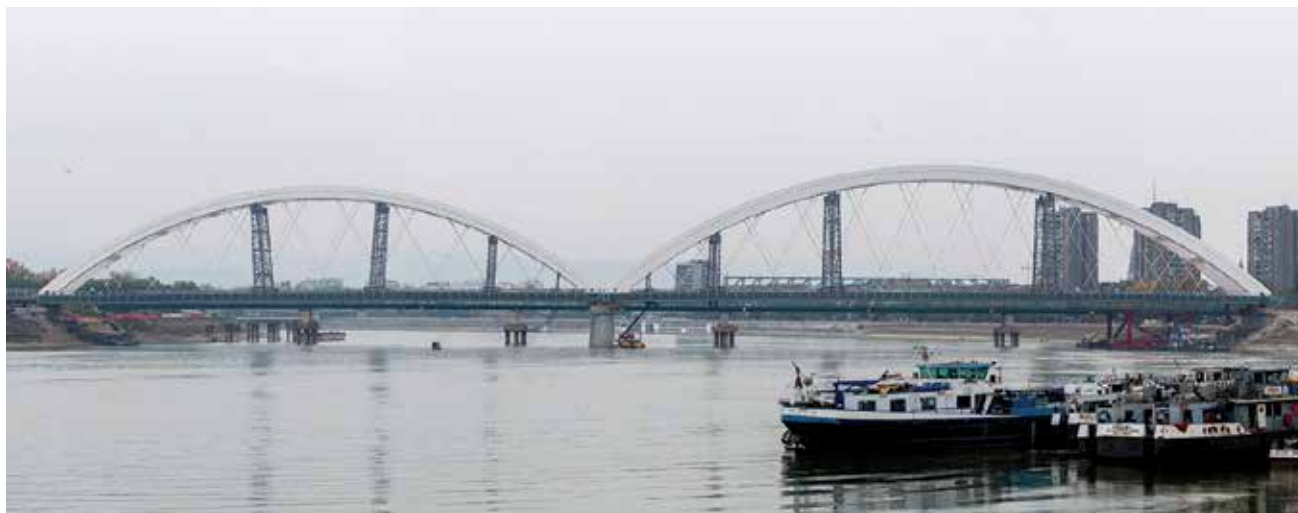
Жежељев мост - железничко друмски лучни мост на Дунаву у Новом Саду. Пројектант Бранко Жежељ. Изграђен 1961. године, срушен у бомбардовању 1999. године
